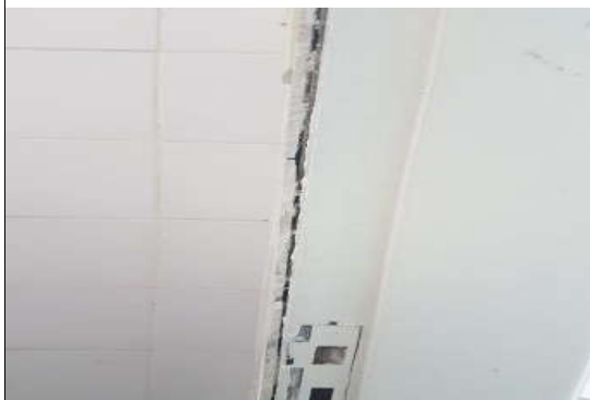
Azulejo onde será instalada cantoneira para acabamento
