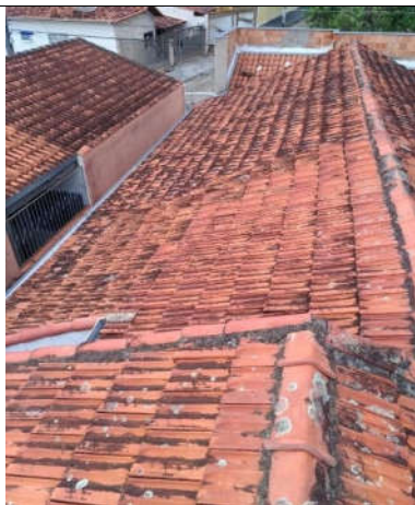
Situação atual do telhado
