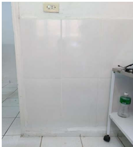
Azulejo existente na sala de triagem
