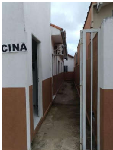
Corredor de acesso à sala de vacina
