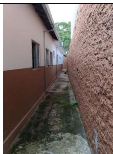
Corredor lateral onde serão instalados ralos
